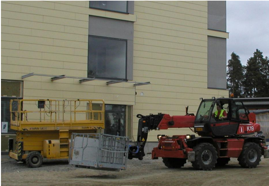
Kuva 6. Rakennustyömaan pääsiirroissa käytetään yleisesti kurottajaa erityisesti pienemmissä kohteissa.
