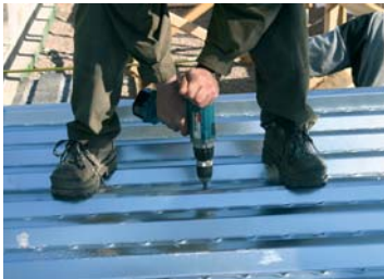
Levyjen kiinnitys porakärkiruuvilla max. väli 500 mm.
