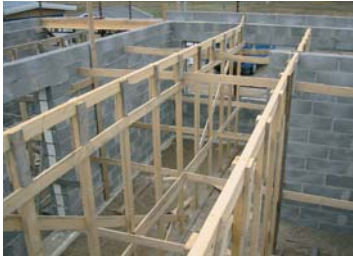
Puusta tehdyt tuet, joiden päälle liittolevyt asetetaan.
