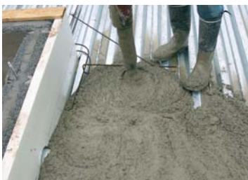
Betoni lasketaan ensin päätyjen ja välitukien kohdalle.
