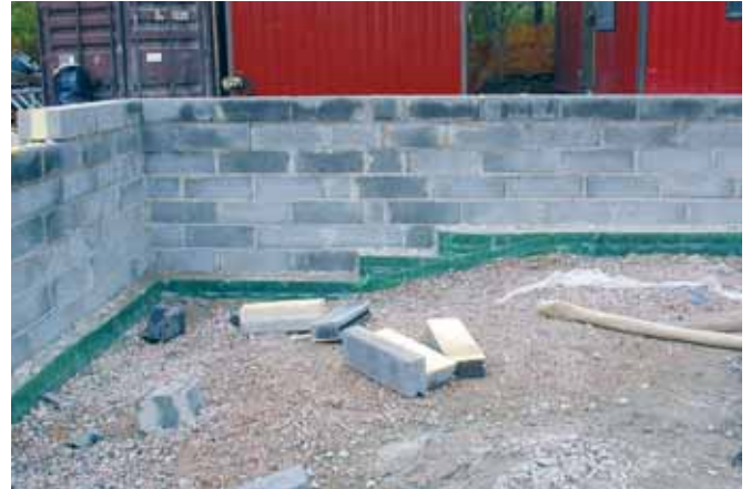
Portaittain toteutettu porrastus harkkoille.
