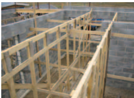
Puusta tehdyt tuet, joiden päälle liittolevyt asetetaan.
