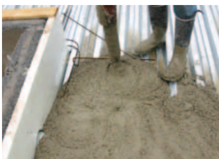
Betoni lasketaan ensin päätyjen ja välitukien kohdalle.
