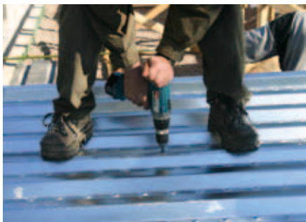
Levyjen kiinnitys porakärkiruuvveilla max. väli 500 mm.
