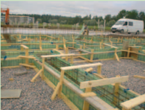
Valulevystä tehtäessä tuenta myös alhaalla.
