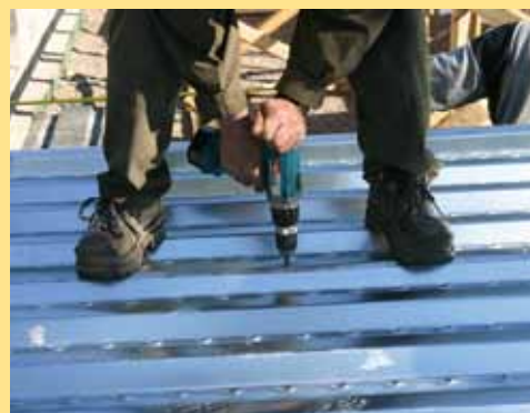
Крепление пластин шурупами-саморезами макс. пролет 500 мм.
