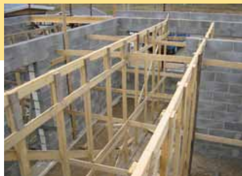
Сначала изготавливаются опоры. Опоры из дерева.
