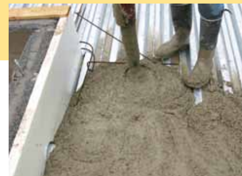
Бетон заливают сначала с торцов и в местах промежуточных опор.
